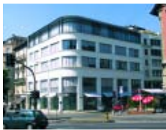
Surélévation de l'ancien garage Peugeot aux Eaux-Vives.
