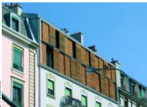
Deux étages de surélévation au 3, rue de St-Léger.
